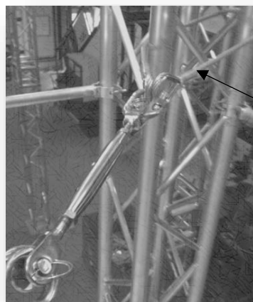
Image 1 : Mettre l'élingue autour de l'ancrage
